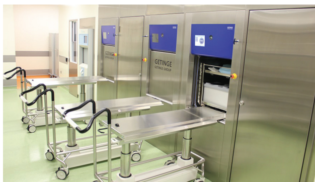
Slika: Centralna sterilizacija – sterilna cona – prehodni parni sterilizatorji
