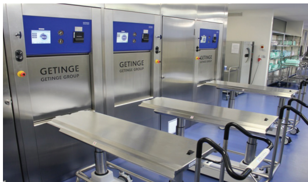
Slika: Centralna sterilizacija – čista cona – prehodni parni sterilizatorji
